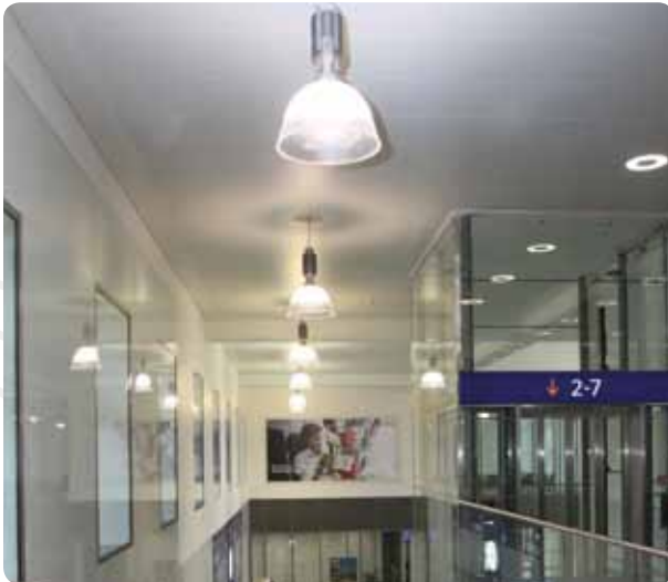
ÖBB Railway Station St.Pölten, AUT
